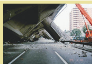
倒壊した阪神高速道路 (1995年阪神・淡路大震災)
