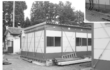
職員2名が生活できる仮設宿舎4戸、既存建物を改修した1戸を整備し、10人前後を派遣できるように調整を進めてきました
